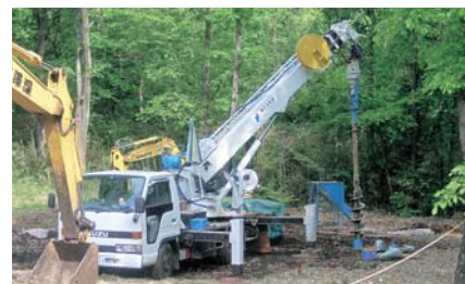
▲天然砕石パイル工法(HySPEED工法)の様子
