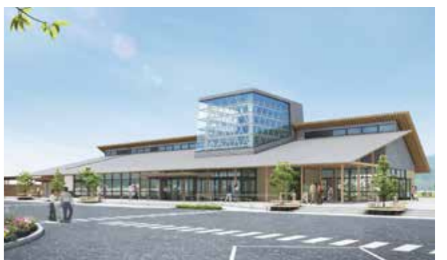
道の駅までい館外観
