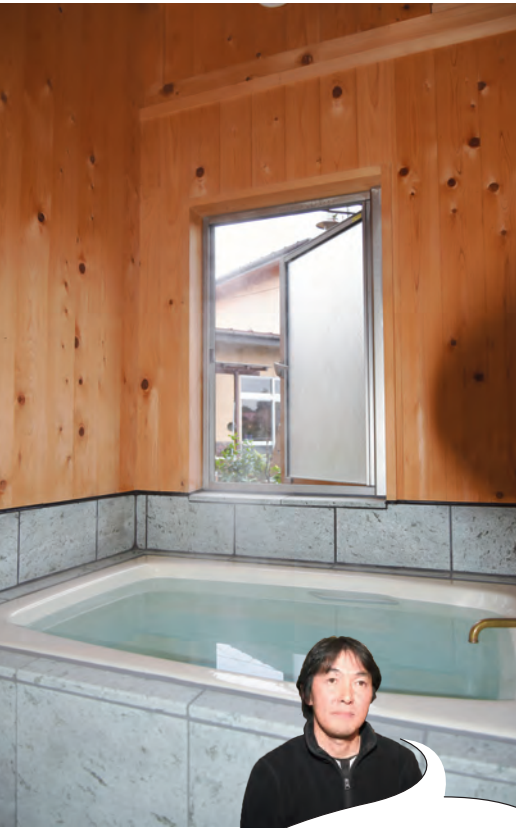
保温性と清潔さを考え、床は石材、壁面には木を使った浴室
